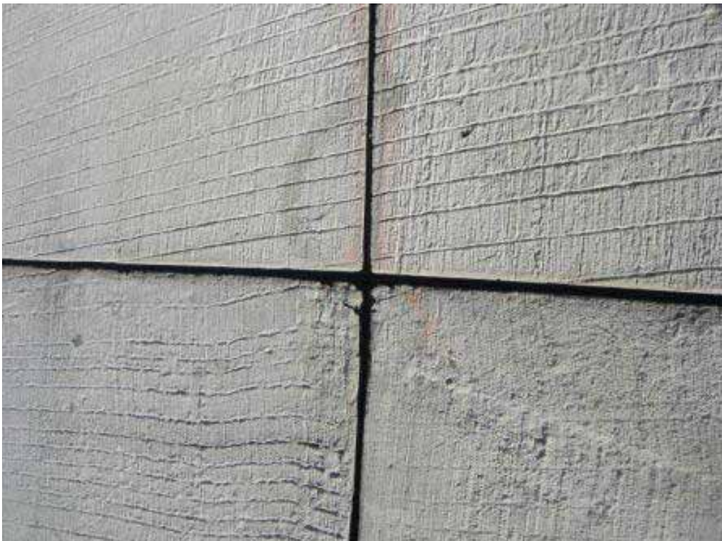
Hot Pour Sealant Installed
