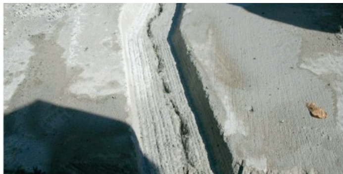
Figure 25. Vertical edge milling
